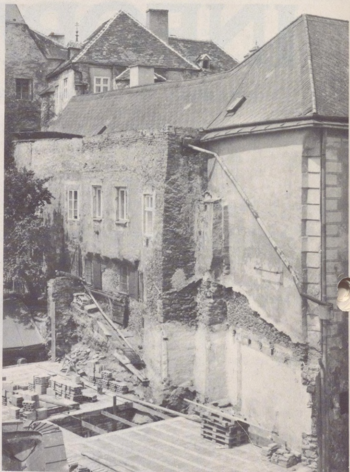
Situation des Fundplatzes vor Errichtung des neuen Obergeschosses. Deutlich sichtbar die Südfassade des Nachbarhauses Wegscheid 7.
