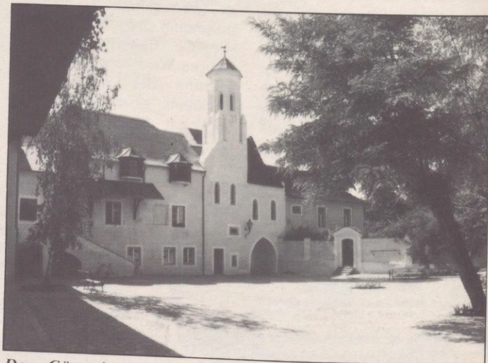
Der „Göttweigerhof“ in Stein vor der Sanierung.
