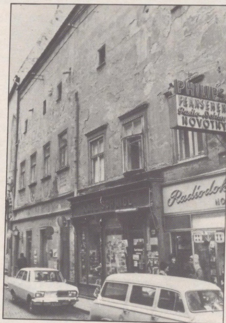
Front des „Bürgerspitales“ in der Landstraße vor der Renovierung.
