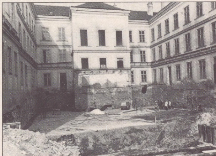
Um Gesamtkosten von 85 Millionen Schilling wird der gesamte Schulkomplex nach Plänen von Architekt Mag. Göbl umgebaut, wobei die Fundamente — das Gebäude steht auf Holzpfählen — generalsaniert werden müssen. Im Innenhof gelangen zusätzliche Klassenräume zum Einbau sowie zwei Turnsäle im Bereich der Front an der Hamerlingstraße.
