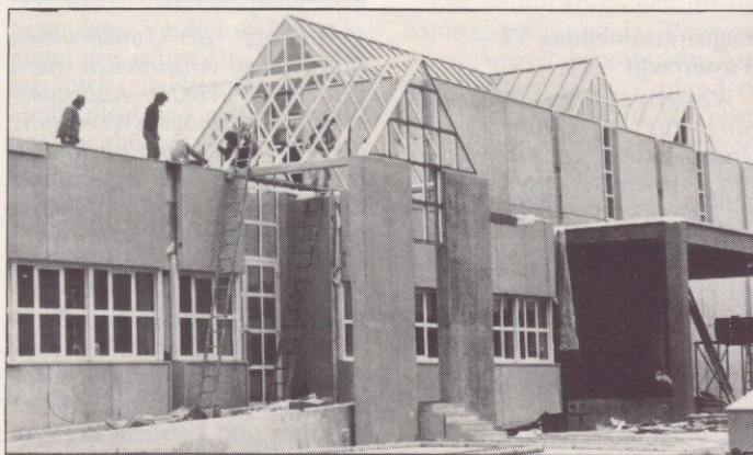
Die Dachfassade des neuen Baukörpers der Austria Tabakwerke AG fügt sich gut in das bestehende Ensemble ein.
