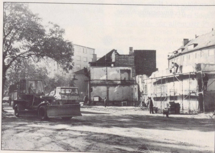
Die alten Gebäude Ringstraße 4 und 8 sind nun abgetragen und die Planierungsarbeiten gehen zügig weiter. Der neu geschaffene Parkplatz mit ca. 80 Stellplätzen wird in Kürze benützt werden können.
